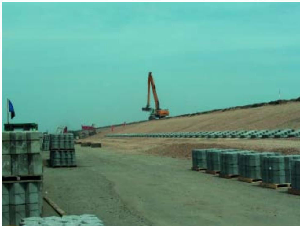
Hondsbossche Zeewering, aanleg ruwe steenbekleding, voorjaar 2005.
